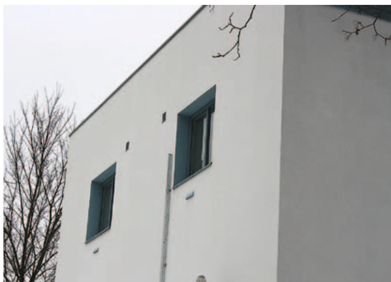
FIGUR 7. Utvendig etterisolering av veggene kan føre til store endringer i fasadeuttrykket. Vinduet blir liggende langt inne i vegglivet dersom man ikke samtidig flytter dem ut. FOTO: NIKU/AC. Flyen, 2017.
