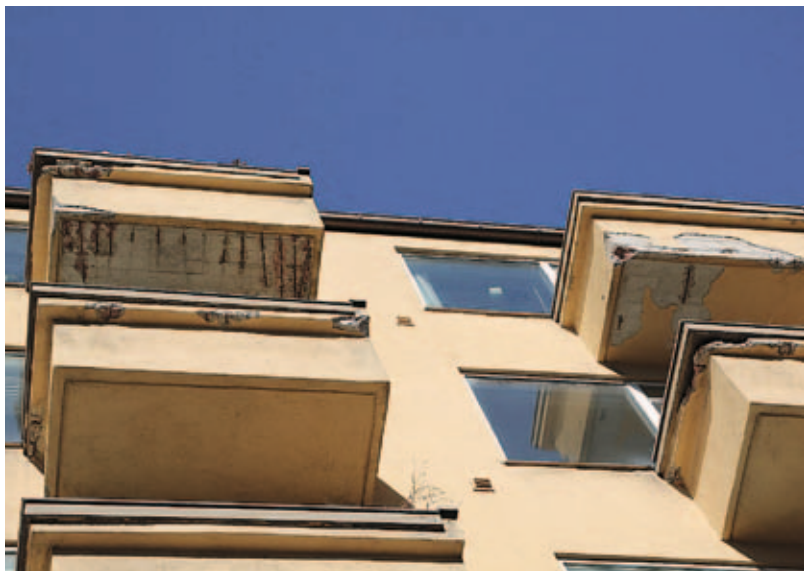
FIGUR 5. Armeringsskader på balkonger på en funkisblokk (Mariesgate/Kirkeveien, Oslo). Karbonatisering er en naturlig kjemisk prosess som oppstår når en betongoverflate er i kontakt med luft. Når karbonatiseringen når inn til armeringsjernet som ligger inne i betongen kommer luft og fuktighet i berøring med jernet. På denne måten korroderer jernet og danner det vi i dagligtale kaller for rust. Rusten har et vesentlig større volum enn jernet, og dette fører til sprengvirkning inne i betongen. Etter hvert vil betongen sprekke opp, og jernet blottlegges. På sikt vil bæreevnen i den armerte betongen svekkes. Jo lavere overdekning over armeringsjernet, jo mer utsatt er konstruksjonen for slik rustsprengning. Under funkis-perioden ble det eksperimentert med liten overdekning for å skape tynne og luftige konstruksjoner. Disse er derfor spesielt utsatt for slike skader. FOTO: NIKU/E. Hole, 2012.
