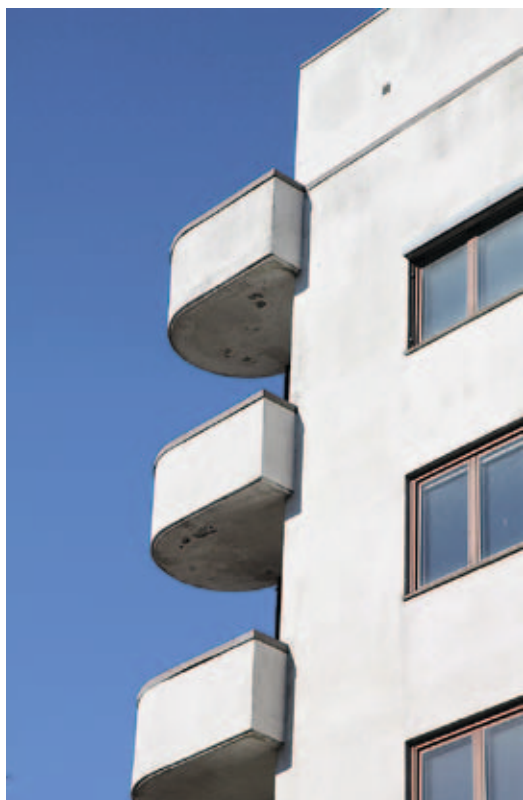
FIGUR 2. Dristige tekniske løsninger som brøt med det gamle kjennetegner funksisarkitekturen. Her balkonger som nærmest svever utenpå bygningskroppen. Middelthuns gate, Oslo. 1938. FOTO: NIKU/E. Hole, 2012.
