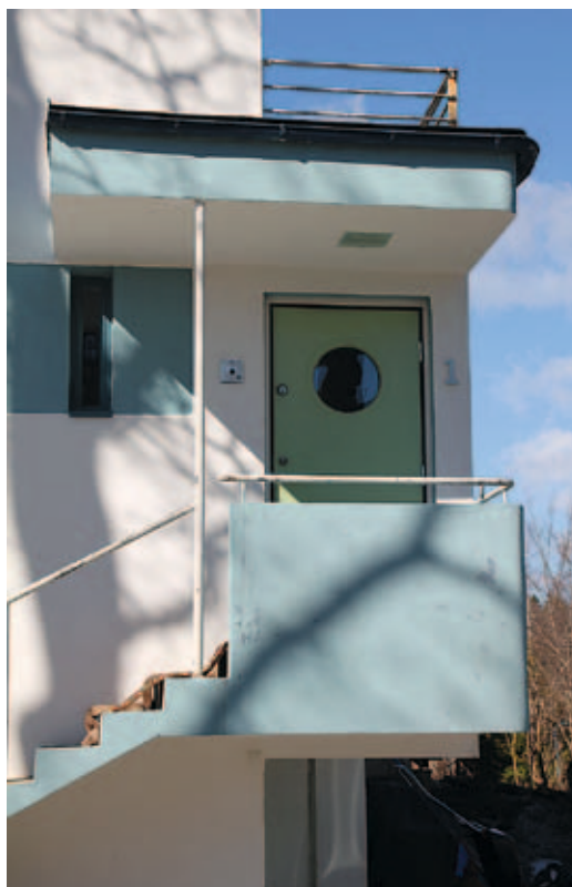
FIGUR 2. Dristige tekniske løsninger som brøt med det gamle kjennetegner funksisarkitekturen. Her balkonger som nærmest svever utenpå bygningskroppen. Middelthuns gate, Oslo. 1938. FOTO: NIKU/E. Hole, 2012.
