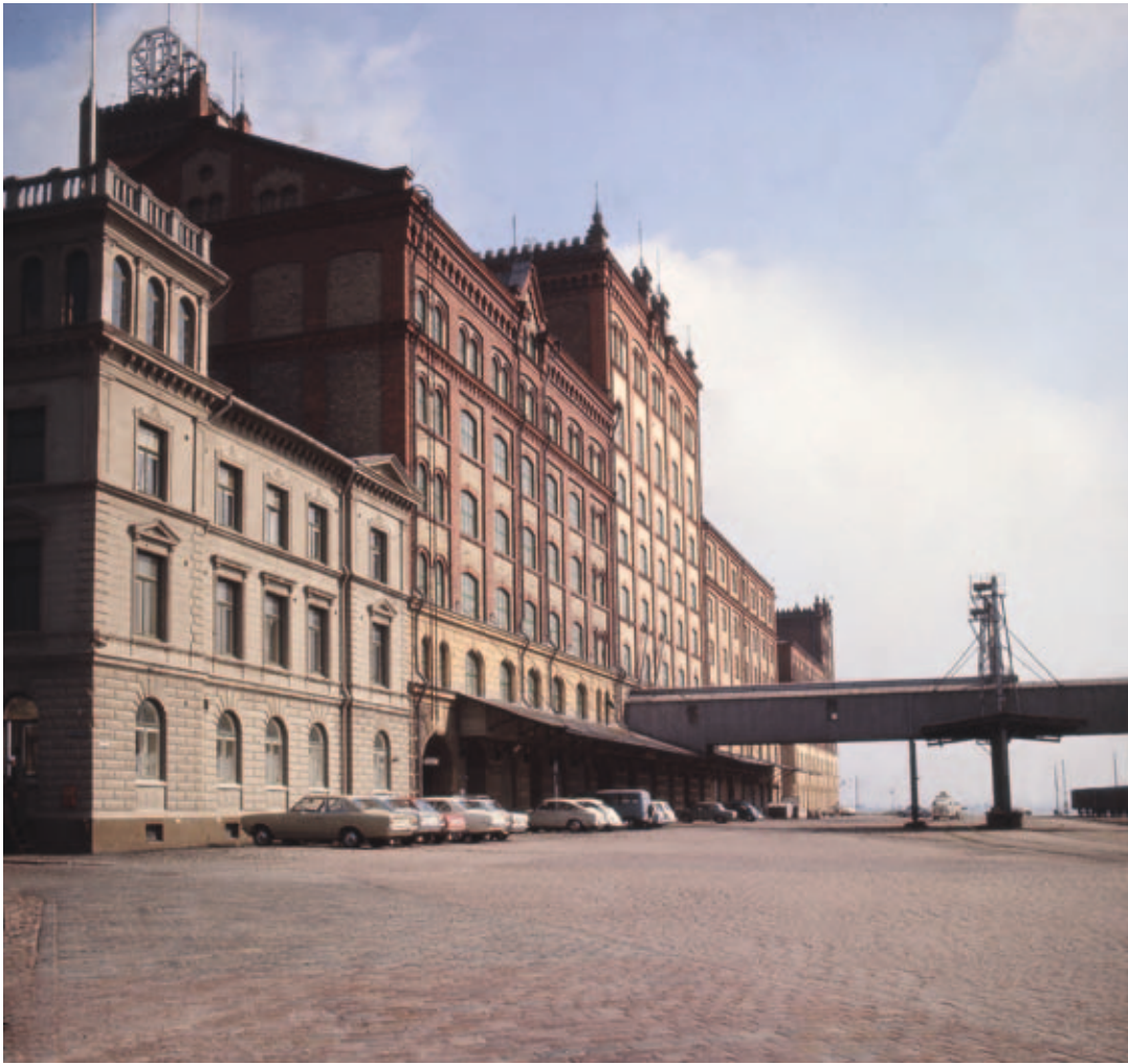
FIGUR 4. Kvarnen i Kalmar, en byggnad som i början av 1970-talet väntade på Mejans användningsplanering. FOTO: Göran Lindahl.
