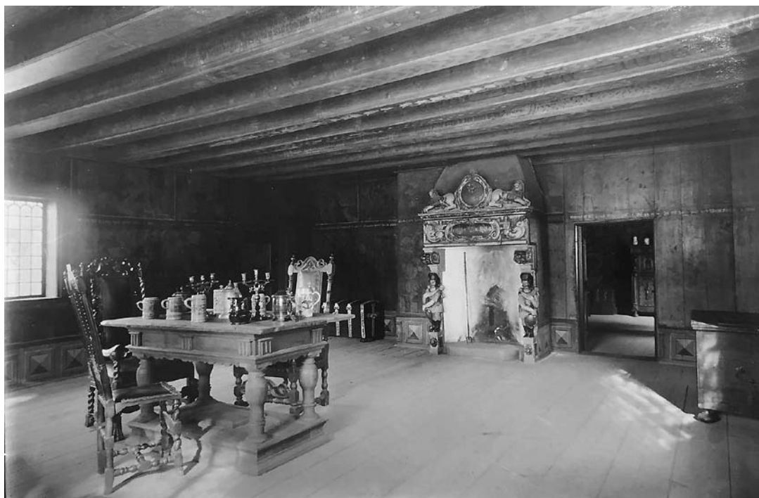
FIGUR 5. Övervåningen av Burmeisterska huset möblerades 1906 och blev ett museum som visades sommardag. KÄLLA: Visby landsarkiv, Landsarkivets fotosamling, vol. T11b:1.
