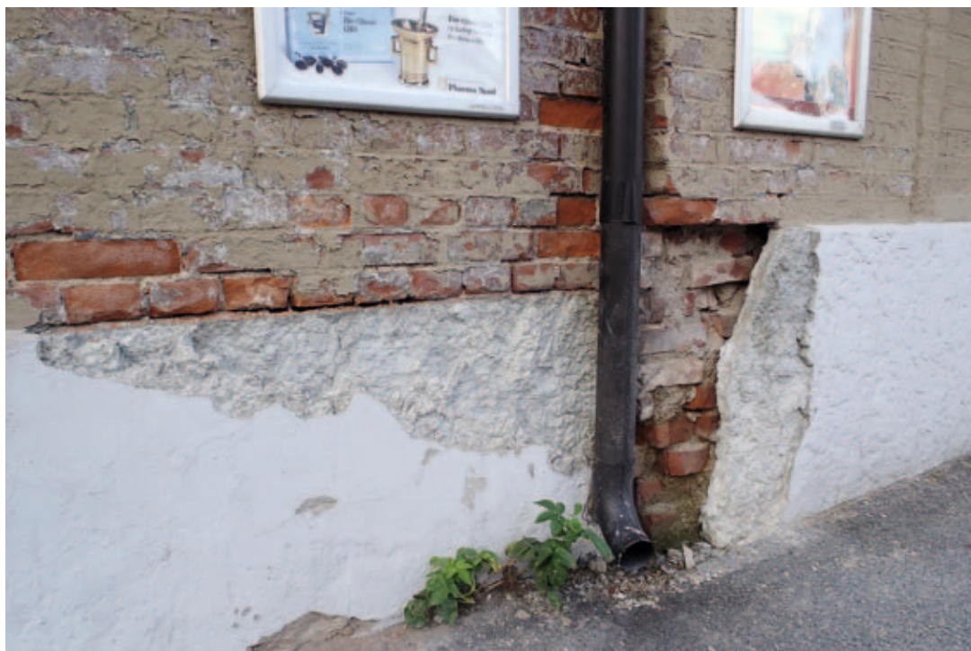
FIGUR 7. Landshövdingehuset vid Kapellplatsen (k i Fig. 1), byggt 1887, har en grå ortoceratitkalksten som sockel. Kalkstensblocken står på högkant vilket medfört en ödesdiger vittring. Särskilt sker detta om kalken är märblig (lerig). Man har målat kalkstenen, troligen för att skydda den, dock har det inte hjälpt i detta fall. Kalkstensytornas karaktäristiska textur går här att urskilja bakom den tunna målningen. FOTO: Erik Sturkell.
