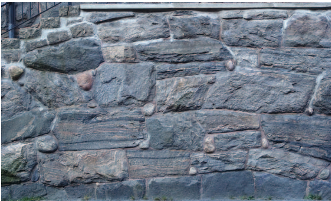
FIGUR 8. Under nationalromantiken fick den lokala gnejsen en renässans, såsom i det påkostade landshövdingehuset vid Erik Dahlbergsgatan 33 ( m i Fig. 1). FOTO: Erik Sturkell.
