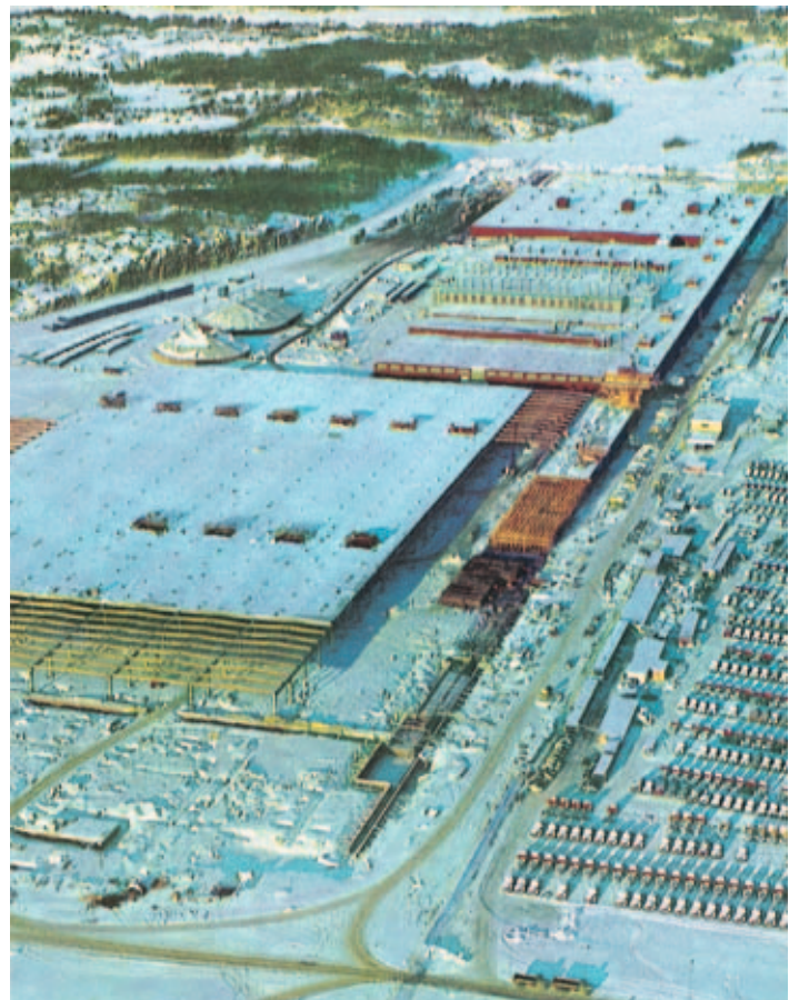
FIGUR 2. Flygbild över Torslandafabriken under uppförande, vintern 1962. I förgrunden monteringsfabriken TC, följd av målerifabriken TB och karossfabriken TA. FOTO: Blom & Andersson, 1984.
