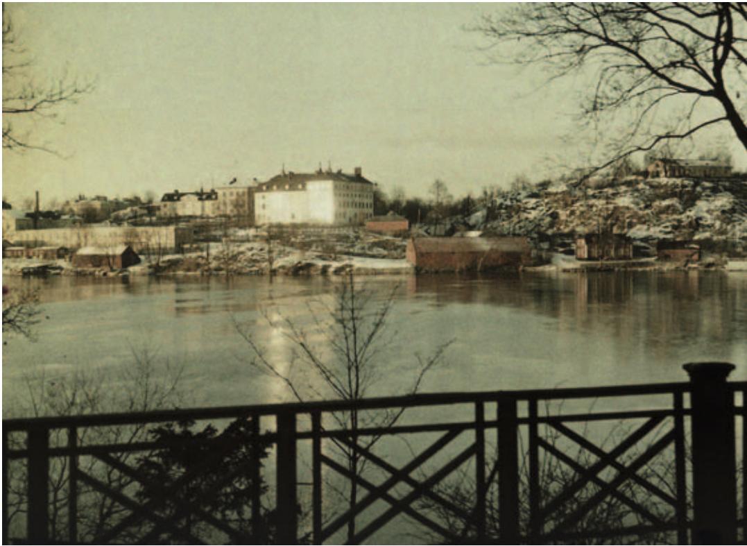
FIGUR 5. Det finns få bilder av ammunitionsfabriken på Marieberg på Kungsholmen, och de flesta är översiktsvyer av detta slag. Detta foto är taget från Långholmen 1926 av Gustaf W:son Cronquist. Den långa trevåningsbyggnaden till vänster är ammunitionsfabriken, och det stora vita huset i mitten är den tidigare porslinsfabriken, som åren 1908–1937 inrymde Kungl. Fälttelegrafkåren. (SSM CRD 2; bilden finns tillgänglig i Stockholmskällan och i Digitala Stadsmuseet.)
