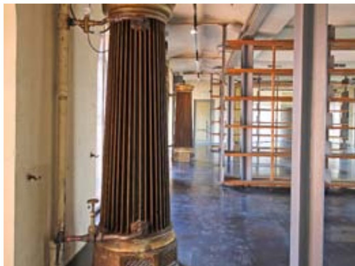
FIGUR 1. Arkivutrymmen på sjunde våningen i Gamla riksarkivet. Huset färdigställdes år 1890. Då var det en, för sin samtid, rationell och brandsäker arkivbyggnad utförd med moderna komforttekniska installationer och nymodig byggnadsteknik. FOTO: AIX Arkitekter AB.
