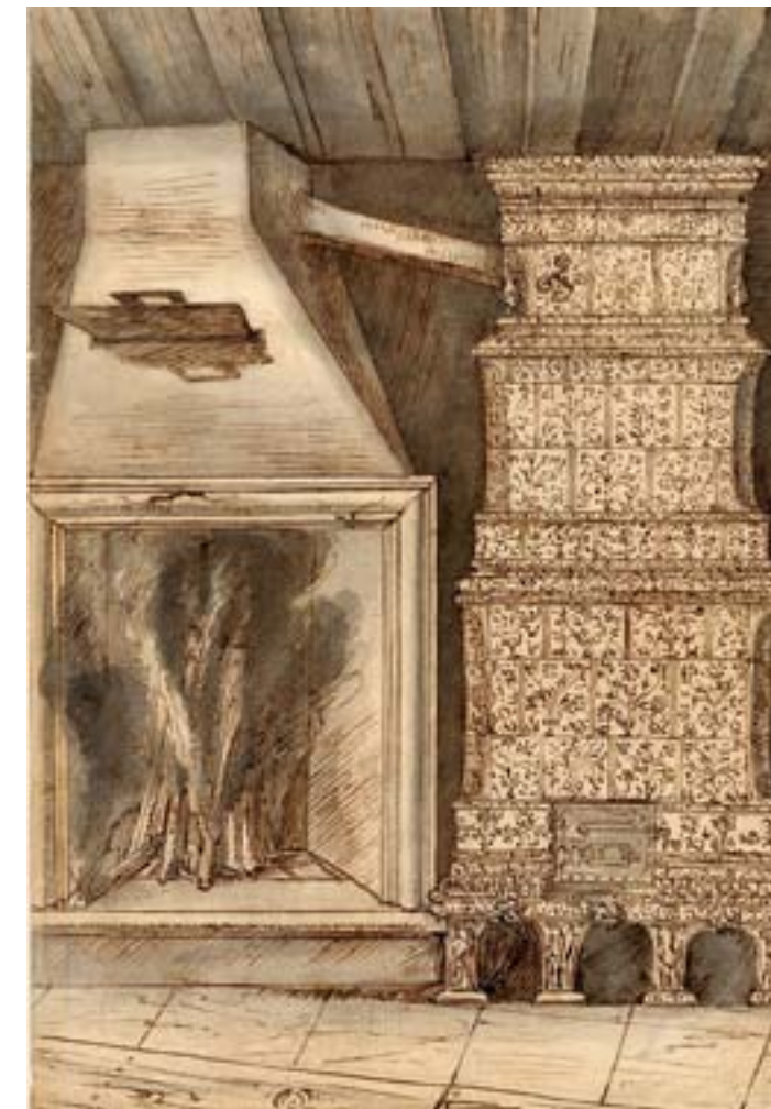
FIGUR 6. Lorenzo Magalottis avbildning av öppen spis och kakelugn på Skoklosters slott från 1674. Under 1600-talet installerades kakelugnarna i anslutning till de öppna spisarnas rökgångar, och alltså inte som enskilda värmekällor. KÄLLA: Uppsala universitetsbibliotek.
