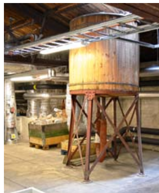
FIGUR 3 & 4. Till vänster står cisternen i sitt ursprungliga läge på vinden. Under cisternen fanns en uppsamlingsbassäng i betong med en ränna som kunde leda bort vatten om läckage skulle uppstå. Till höger syns cisternen i sitt nya läge, omgiven av de senaste ventilationstekniska tilläggen. FOTO: AIX Arkitekter AB.
