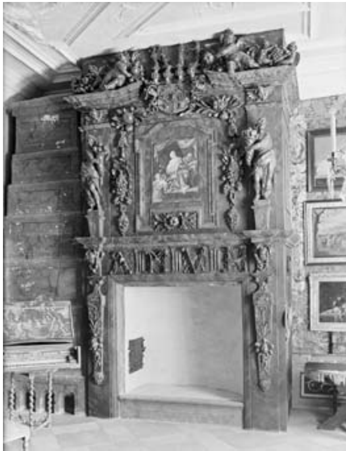
FIGUR 10. Uppvärmningsanordning i grevinnan Wrangels förmak (2B). Intill den öppna spisen har man uppfört en tegelugn. Tegelugnens öppning är belägen inne i den öppna spisen vilket tyder på att man inte har eldat direkt i tegelugnen utan använt glöden från brasan som sedan värmt tegelugnsväggarna. FOTO: Ekberg 1946, Nordiska Museets arkiv.
