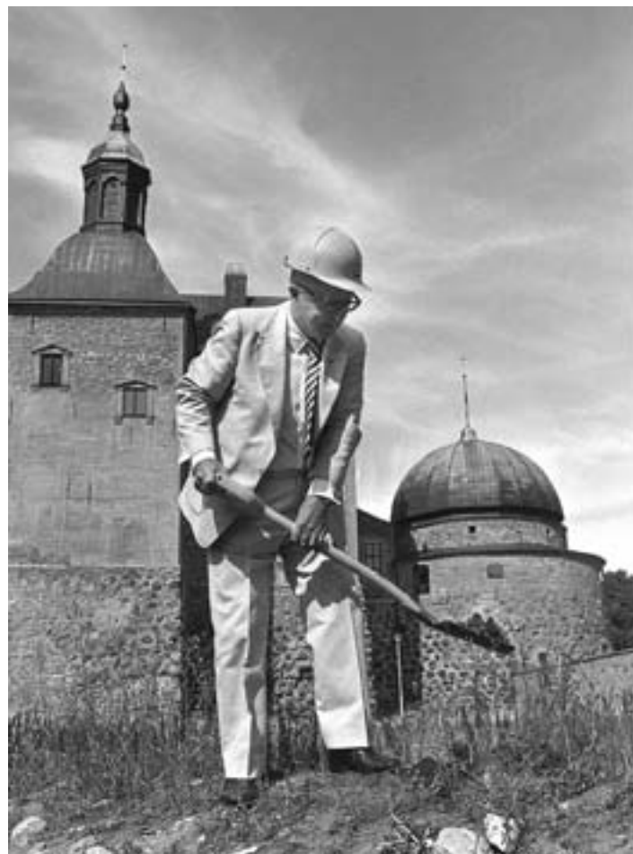
FIGUR 10. Landsarkivarie Arnold Sandberg tar det första spadtaget för uppförande av de nya vallarna i augusti 1982. FOTO: Åke Svensson.
