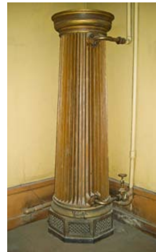
FIGUR 5. De flesta radiatorerna fick en arkitektonisk gestaltning i form av låga kolonner. FOTO: Mia Geijer.
