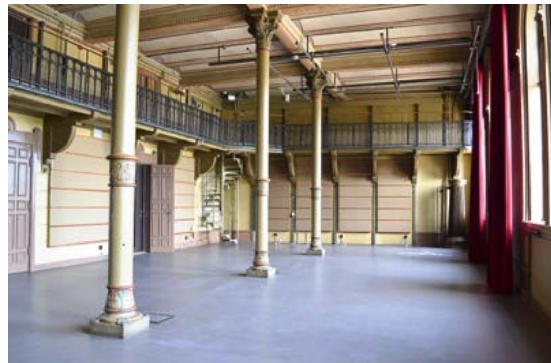
FIGUR 6. Forskarsalen med ursprungliga kolonnradiatorer och ventilationsöppningar. Idag är ventilationen kompletterad med moderna ventilations aggregat i form av paneler. FOTO: AIX Arkitekter AB.
