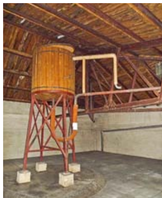
FIGUR 3 & 4. Till vänster står cisternen i sitt ursprungliga läge på vinden. Under cisternen fanns en uppsamlingsbassäng i betong med en ränna som kunde leda bort vatten om läckage skulle uppstå. Till höger syns cisternen i sitt nya läge, omgiven av de senaste ventilationstekniska tilläggen. FOTO: AIX Arkitekter AB.
