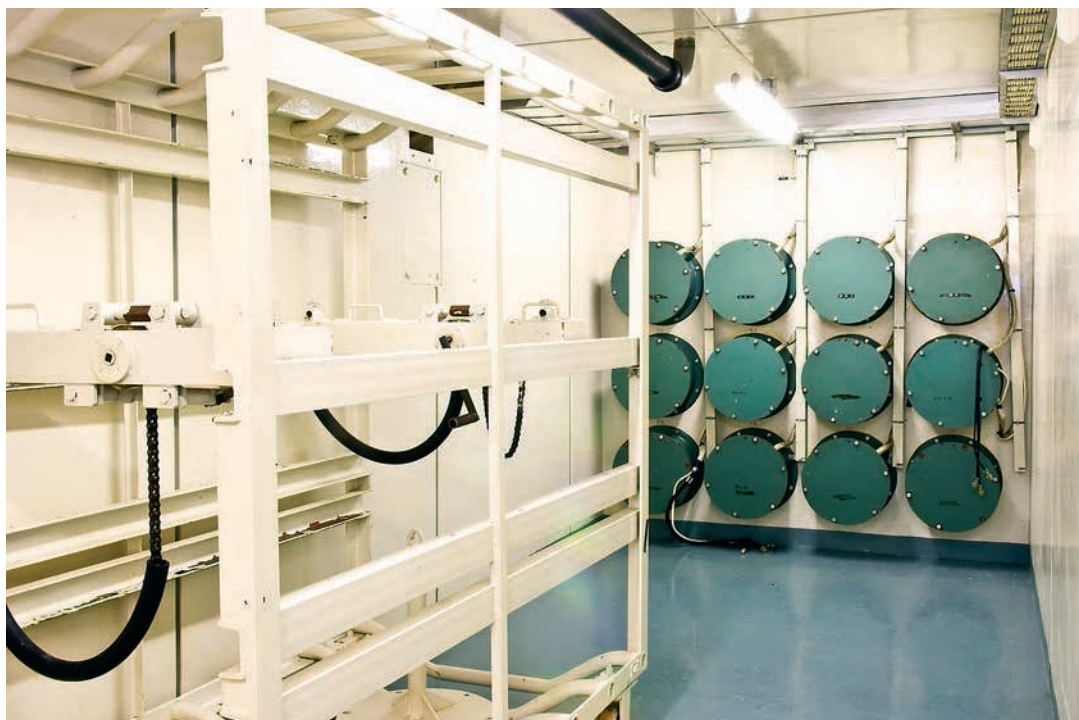
FIGUR 5. Jonkammare, rum för neutronflödesmätning. Dessa flöden var särskilt viktiga att kunna kontrollera eftersom de visar reaktorns effekt men också är helt avgörande ur säkerhetssynpunkt. En subtil mätutrustning användes med flera överlappande mätkedjor. Om neutronflödena var för höga, blev reaktorn överkritisk och utlöste snabbstopp. FOTO: Nisse Cronstrand, Tekniska museet.
