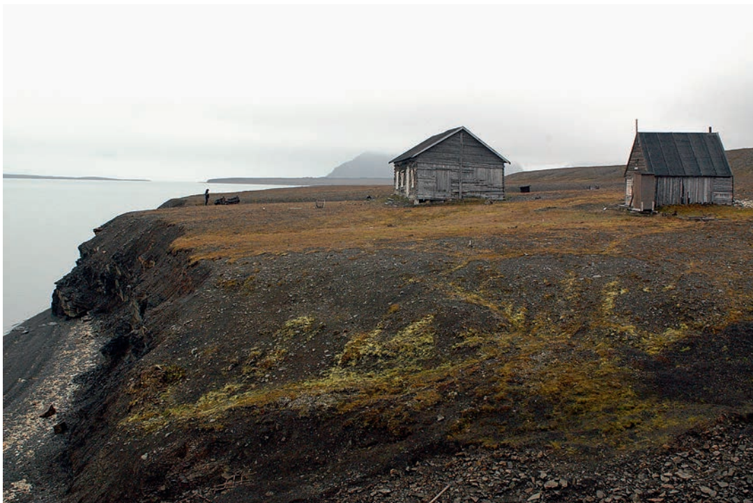
FIGUR 4. Camp Morton, Van Mijenfjorden, Spetsbergen – en aktant i Sveagruvans lokala nätverk. AB Spetsbergens Svenska Kolfält använde byggnaderna som mellanstation och tillfälligt skydd för transporter av personal och varor mellan iskanten i Bellsund (vattenytan som syns i bakgrunden) och Sveagruvan. FOTO: Dag Avango, 2006.
