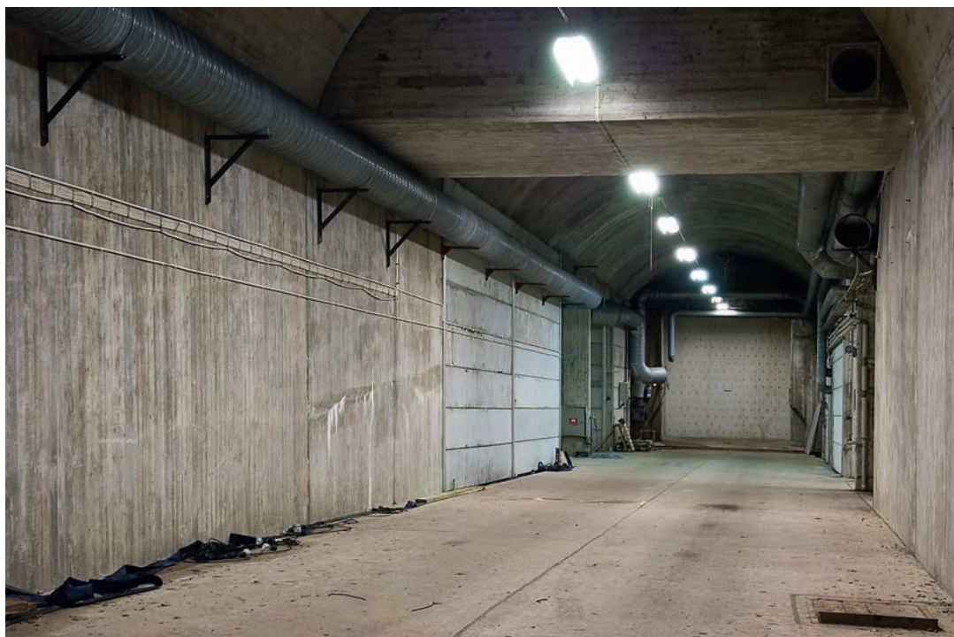
FIGUR 6. Transporttunnel in till reaktorhallen. Bilden tagen med riktning mot yttre slussporten. Här tvättades alla fordon innan de tilläts köra in och ut ur slussen. FOTO: Nisse Cronestränd, Tekniska museet.
