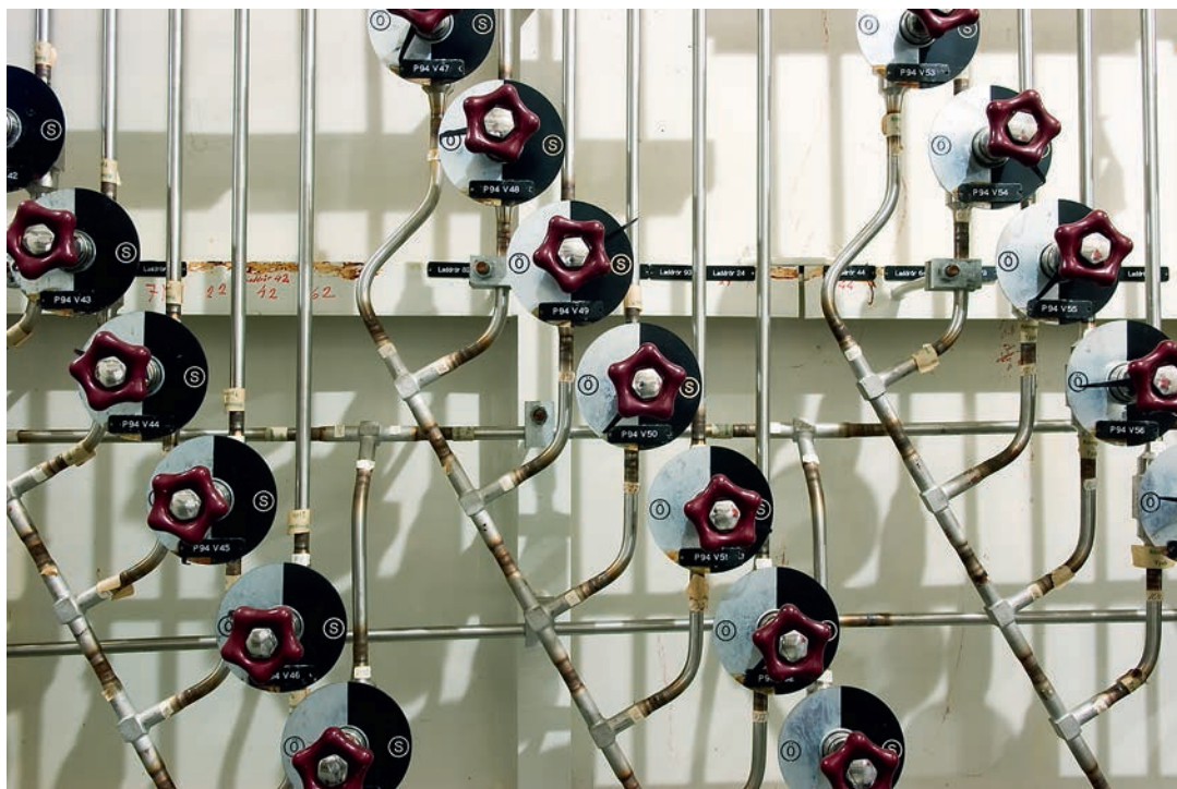
FIGUR 3. Ågestaverket rymmer många mil av rör i olika dimensioner och ger prov på den ingenjörskonst som Ågestaprojektet stod för. De atomtekniska kraven på driftssäkra konstruktioner var mycket höga, dels för att det handlade om radioaktiv verksamhet, dels för att det tunga vattnet var oerhört kostsamt och inte fick läcka ut. FOTO: Nisse Cronstrand, Tekniska museet.
