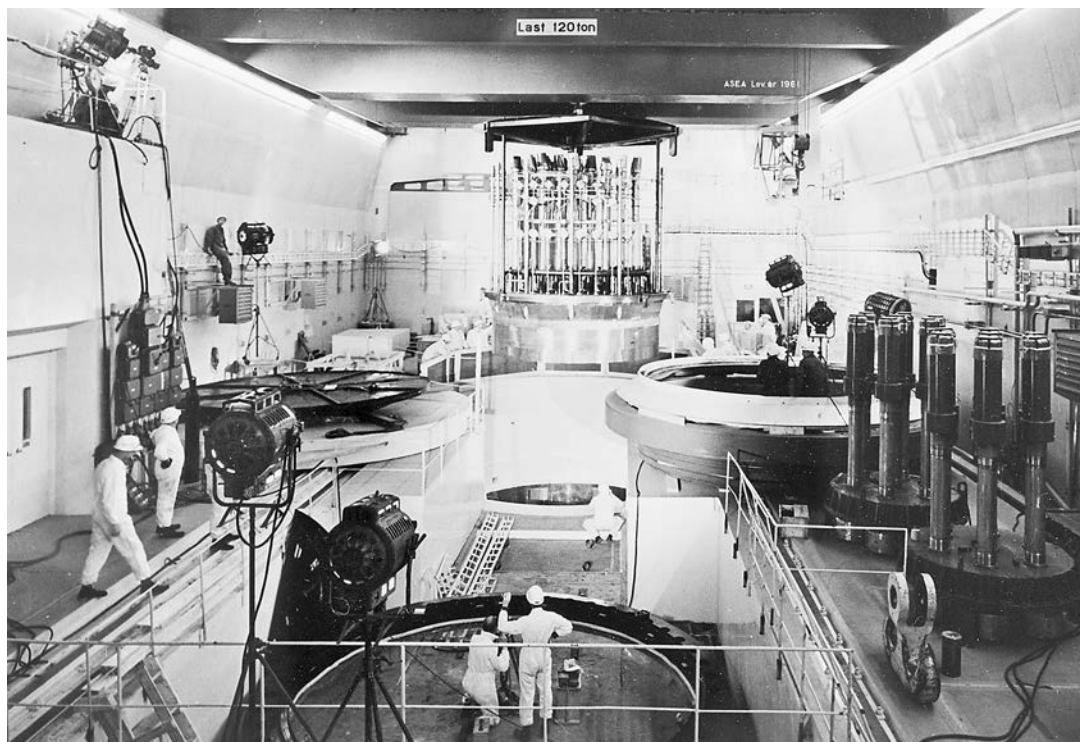
FIGUR 7. Provdrift i Ågestaverket 1962. Bilden är tagen i samband med slutmontage av reaktorn. Reaktorlocket med tillhörande "rörskog" håller på att sänkas ner för att anslutas till reaktortanken. FOTO: Tekniska museets arkiv.
