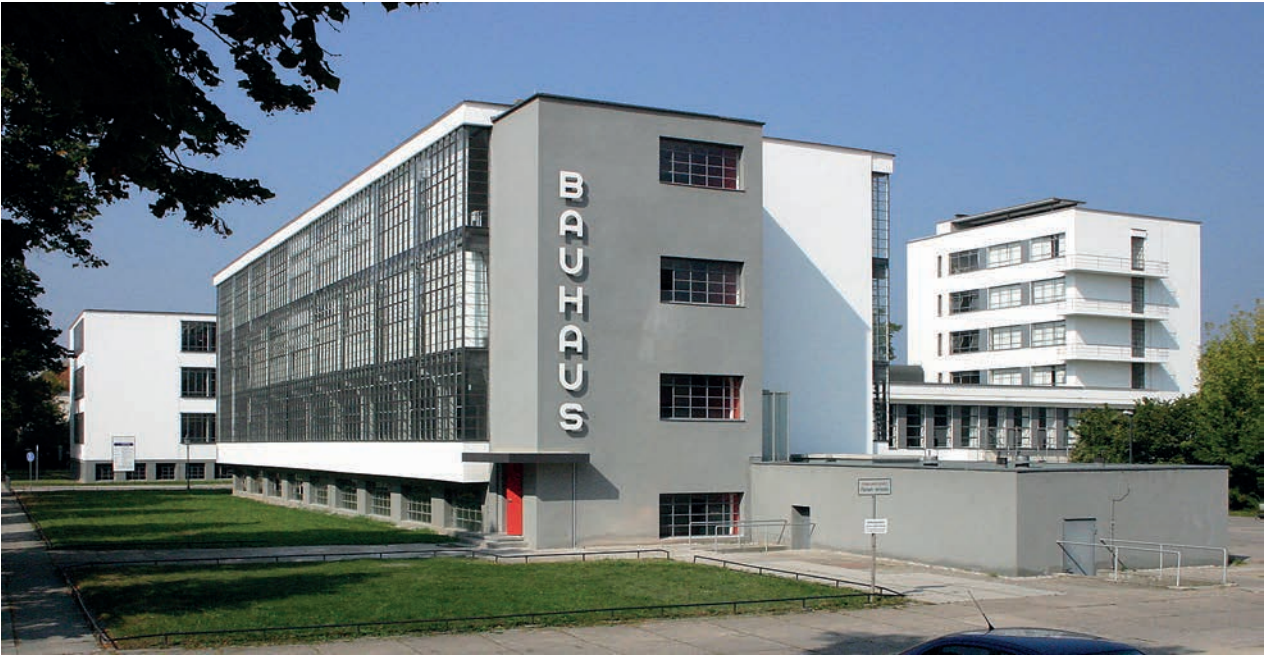
FIGUR 1. Bauhausskolan i Dessau ritades av Walter Gropius och invigdes 1926. Byggnaden ingick tidigt i en modern arkitekturhistorisk kanon, och den restaurerades i flera omgångar från 1970-talet och framåt. Sedan 1980-talet är anläggningen ett kulturcentrum, med bland annat undervisning och forskning på programmet. Bauhausskolan blev världsarv 1996. FOTO: Jutta Stein 2005. Bauhaus Dessau Foundation.
