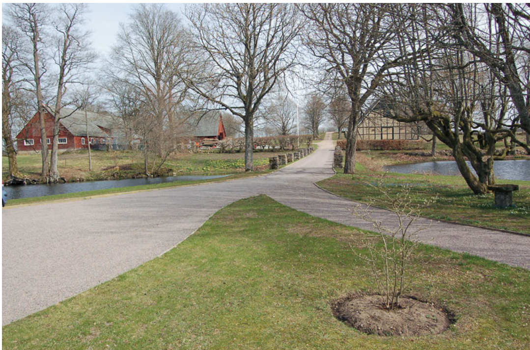
FIGUR 2. Ekonomigården mot öster. Den består av två parallella längor, koladugården i norr (till vänster på bilden) häststallet i söder (till höger på bilden) och tröskklogen i mitten. Av den senare återstår bara en tredjedel. Alla byggnaderna är i skiftesverk och strukna med faluröd färg utom stallängans västra gavel som är i korsvirke med tegel. Alla tak utgörs av korrugerad eternit. Foto Ulrich Lange.
