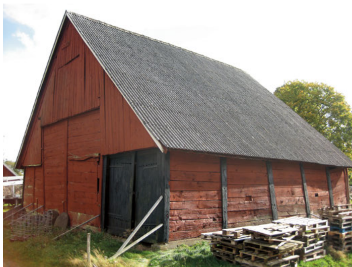
FIGUR 4. Logen sett från nordväst med den ursprungliga porten till västra sidoskeppet. Betonggrunden och den utvändiga temporära försträvningen framgår, liksom de små uthuggna luftgluggarna in mot gården. Foto Karl-Magnus Melin.
