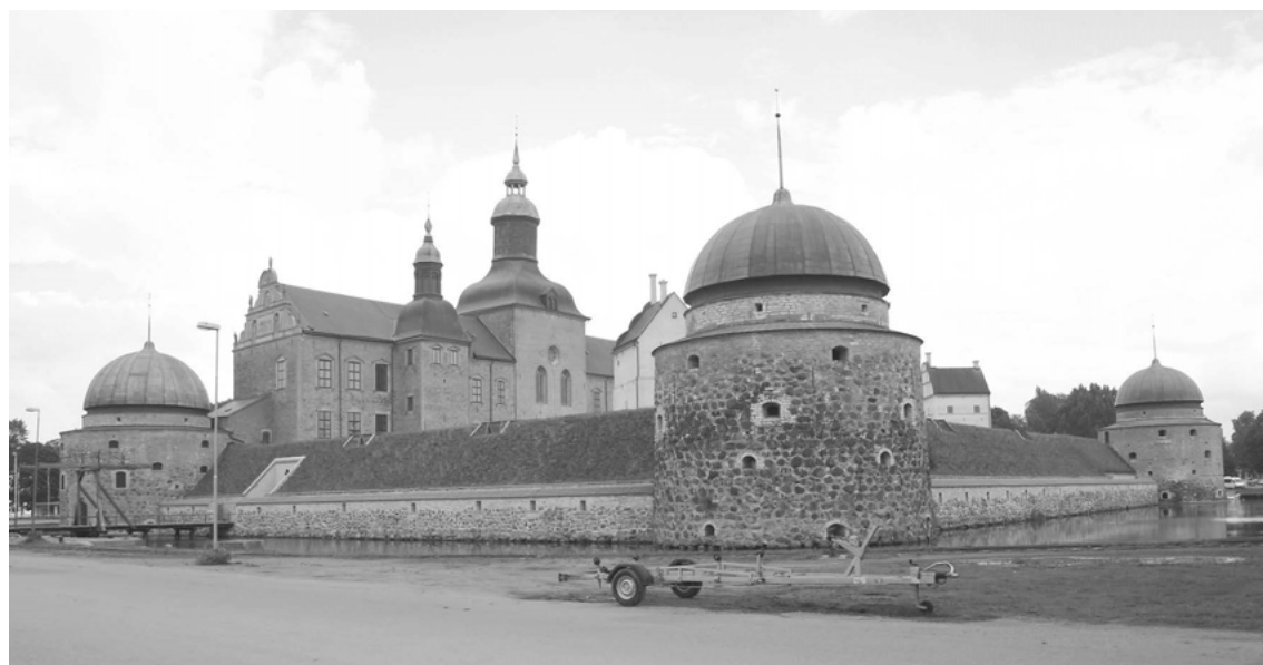
FIGUR 7. De nya vallarna och hörntornen i Vadstena har rekonstruerats till form och ytmaterial. Under vallarnas yta döljer sig helt moderna konstruktioner. Till vänster syns den nya bron till borggården, som möjliggör tunga godstransporter till slottet. Foto H. Geijer.
