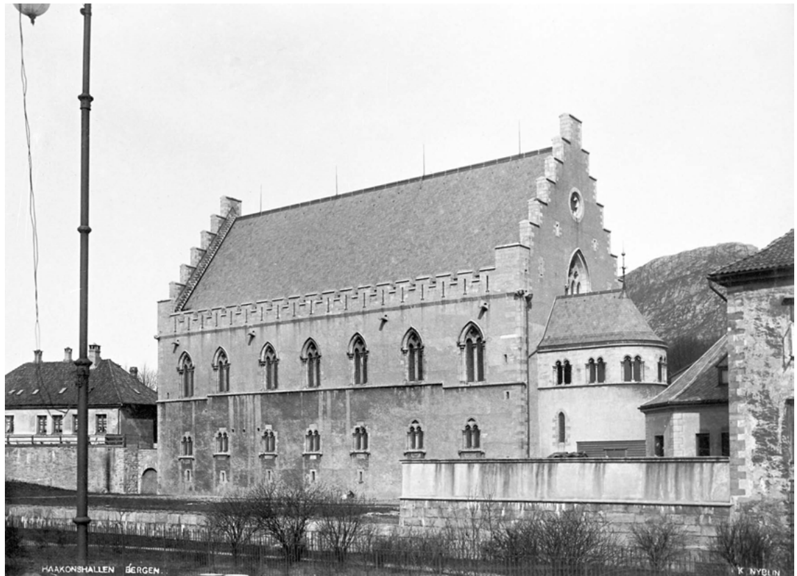
FIGUR 4: Håkonshallen sett fra sjøsiden, slik den så ut som ferdig restaurert rundt 1900. Det er verdt å merke seg hvor likt det ferdige resultatet ble de tegningene som ble fremlagt i NORSKE BYGNINGER FRA FORTIDEN. Bildesamlingen, Universitetet i Bergen .
