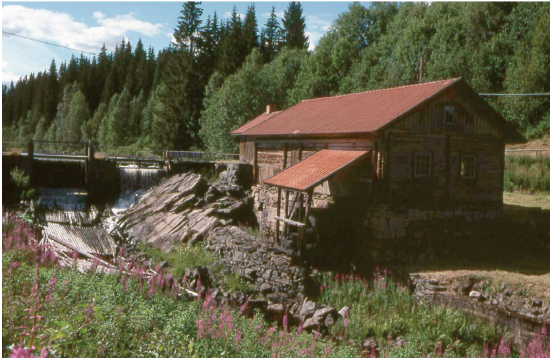
FIGUR 4. Röjdåfors kvarn i Östmark byggdes 1859 och var i drift till 1960. Kvarnen består av två par kvarnstenar drivna av var sitt vattenhjul och är typisk för vattendrivna kvarnar i Värmland. Byggnadsminne 1971. FOTO: Gert Magnusson.
